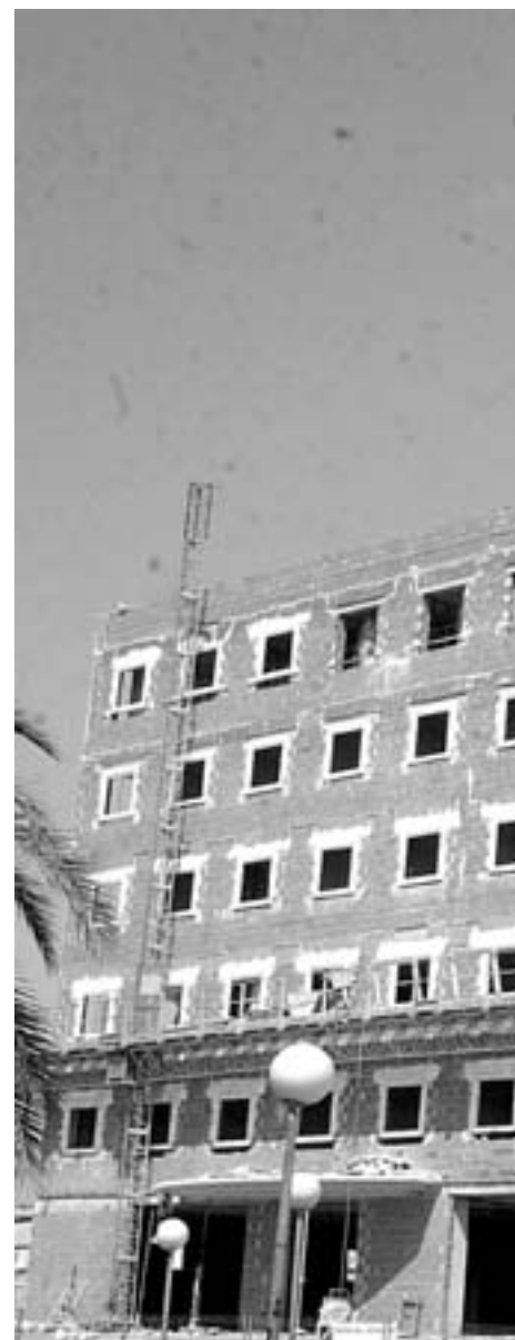
VIENTO EN POPA. Construcción
