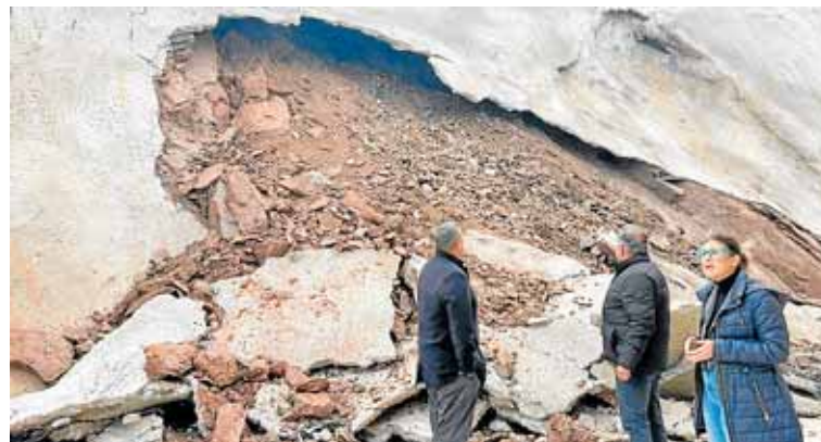
Medina y los concejales de Seguridad y Contratación ante el talud. AYTO.
