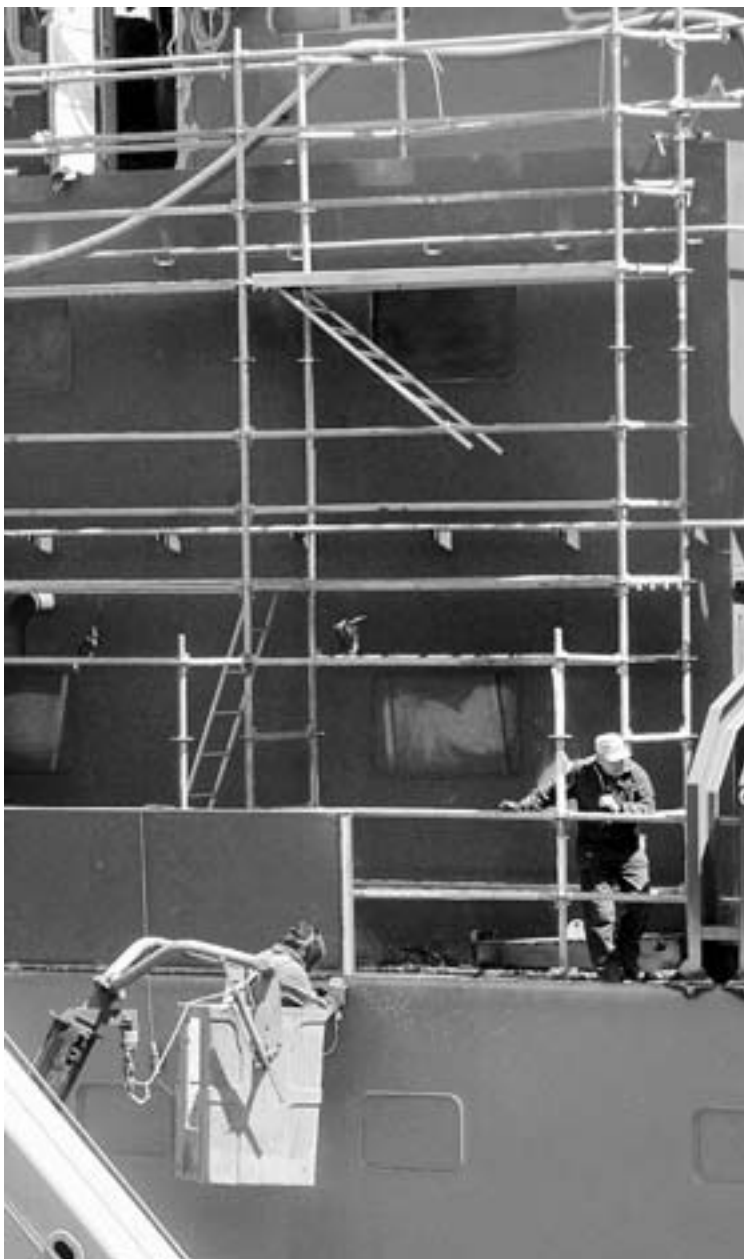
IZAR. Trabajos de reparación del 'Hespérides'. / ANTONIO GIL / AGM
