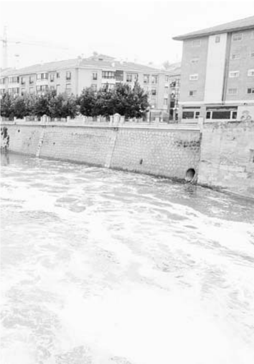
por la pasarela Manterola y el Puente de los Peligros de Murcia. / JUAN LEAL
