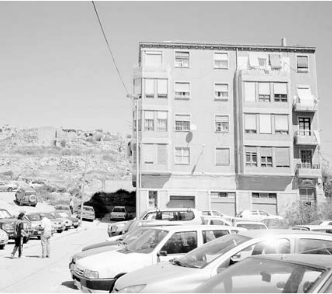
EN PIE. Uno de los pocos edificios del Molinete que aún no ha sido derribado. / PABLO SÁNCHEZ / AGM
