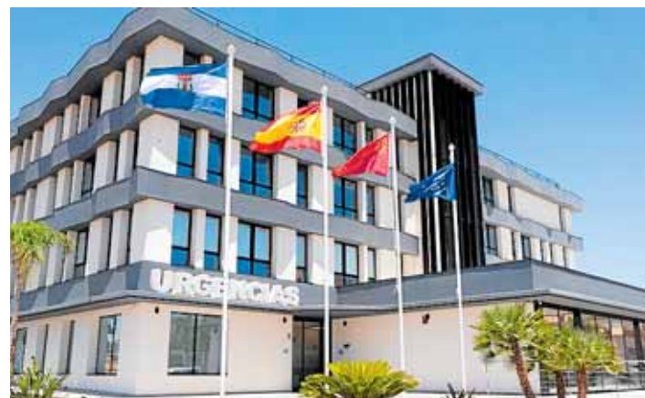
El centro está ubicado en el paseo de los Rosales, 42, en Águilas,
