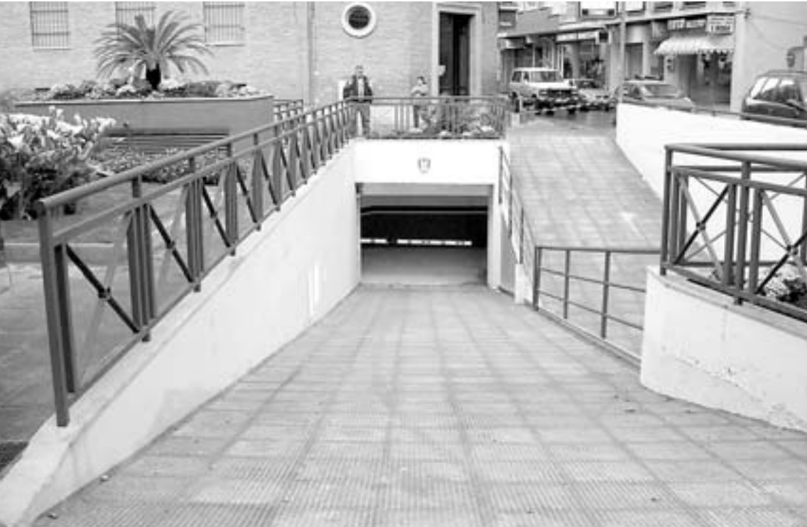
ENTRADA Y SALIDA. Rampa de salida de vehículos a la calle Lope Gisbert y al fondo la entrada. / A. H.
