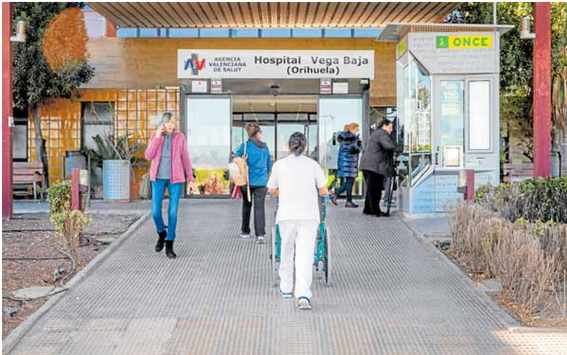
Entrada principal, ahora en obras, del Hospital Vega Baja. EVA MOYA
