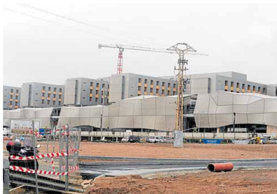
Construcción del Hospital Santa Lucía de Cartagena, en el año 2010. ANTONIO GIL / AGM
