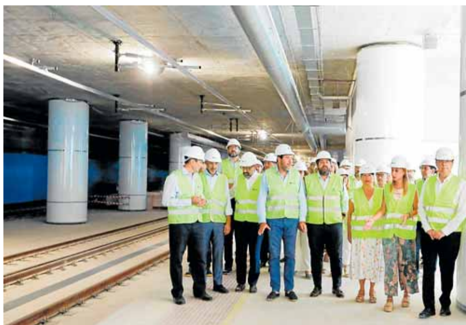
El ministro Óscar Puente y López Miras, en las obras de la estación de Murcia. EP
