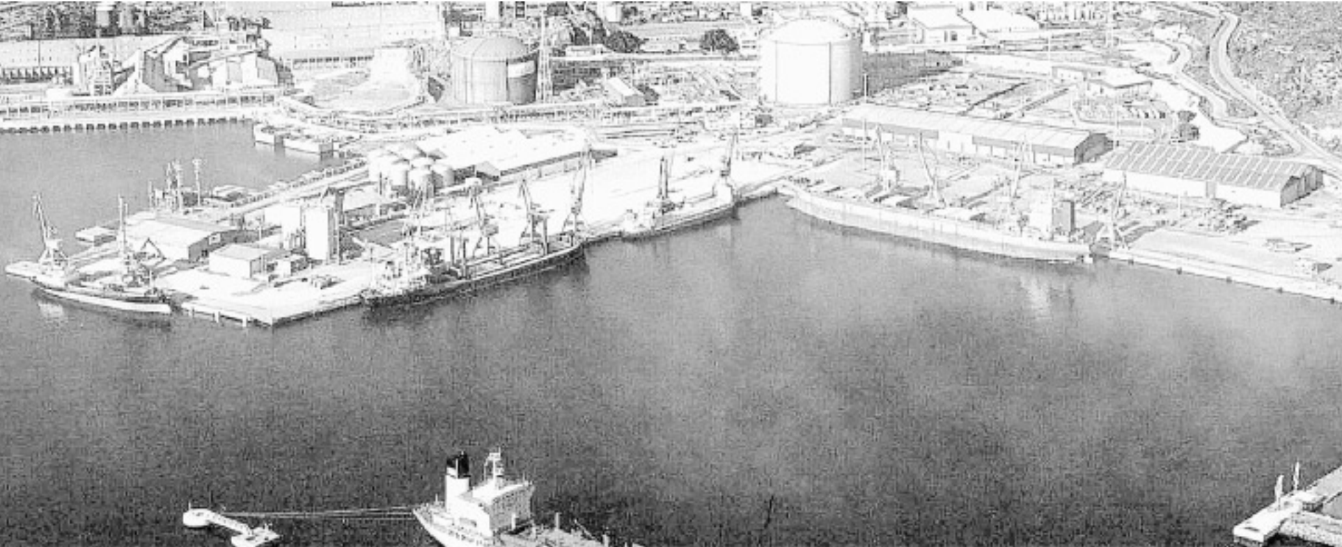
LA PUERTA DE ENTRADA. En la imagen, la planta regasificadora instalada en el Puerto de Cartagena, propiedad de Enagas / LA VERDAD
