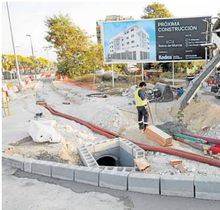
Detalle del entubamiento de la acequia Casteli che. NACHO GARCÍA
