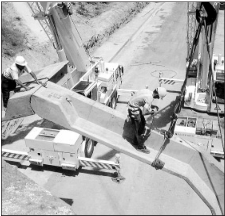
UTE Dos operarios colocan los soportes para un bóveda de la Autovía del Noroeste.
