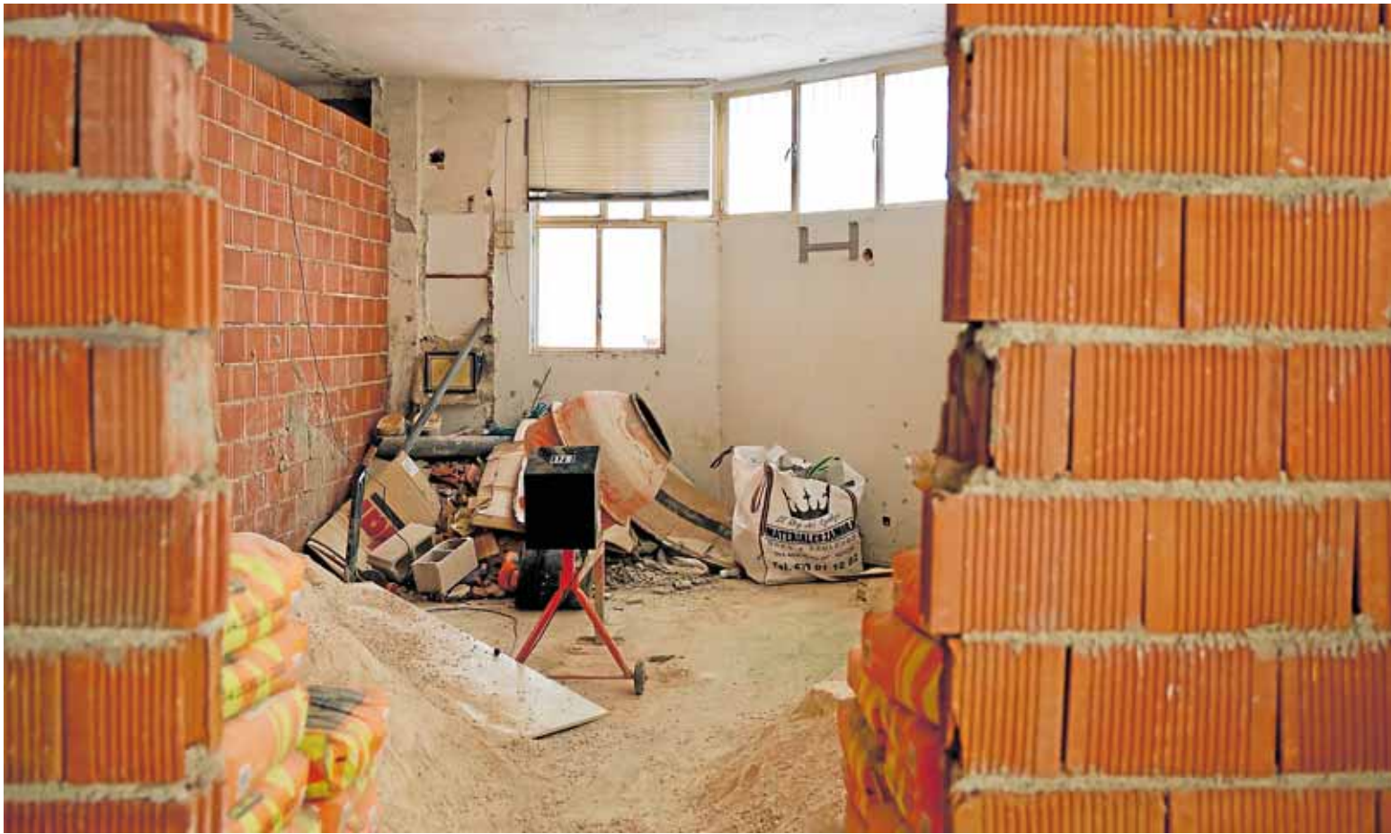
Obras en uno de los bajos comerciales que a lo largo del año pasado se convirtieron en vivienda en Murcia. NACHO GARCÍA
