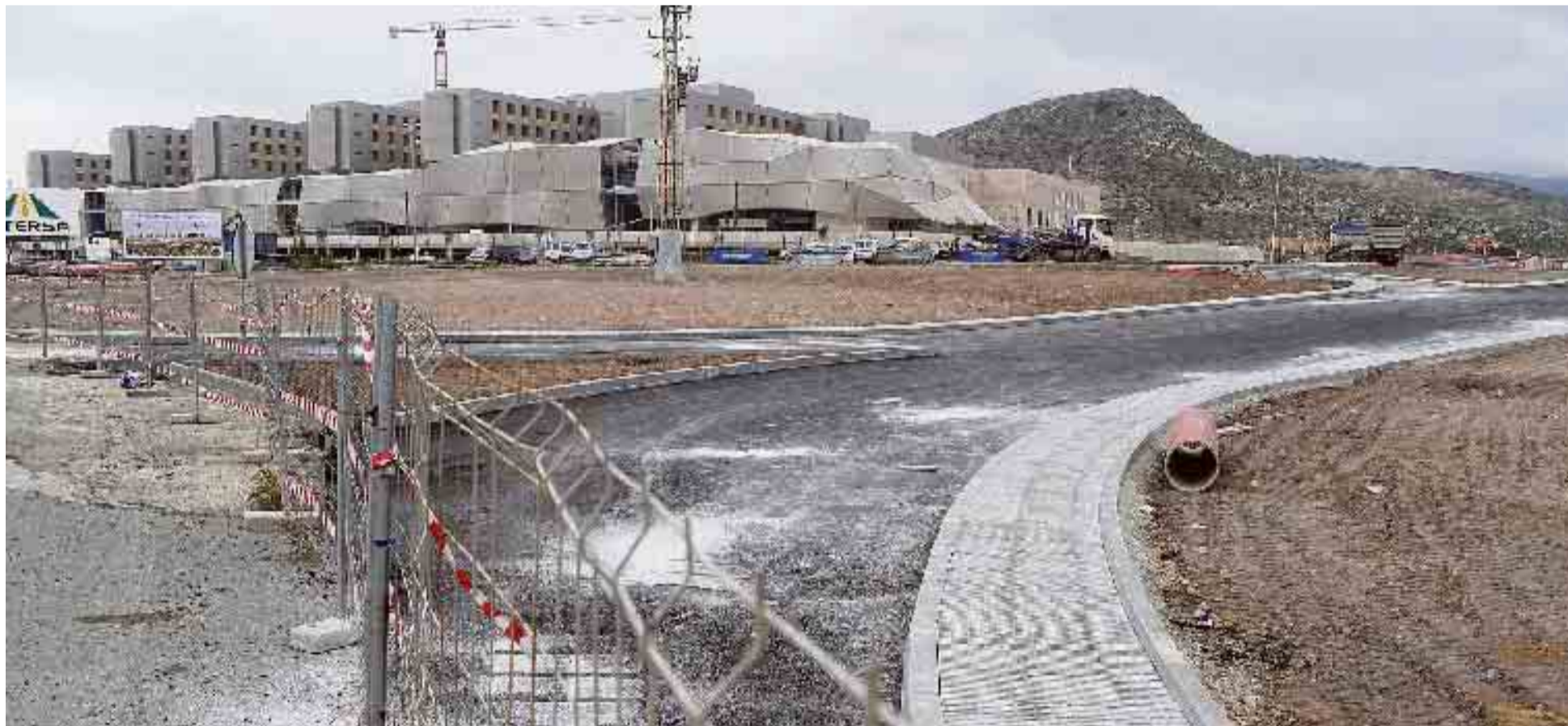
Estado de las obras del nuevo hospital que es construido por la Comunidad en Santa Lucía, en una fotografía de hace unos días. :: ANTONIO GIL / AGM
