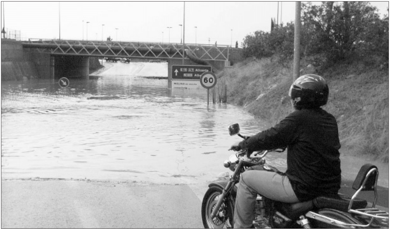
Un motorista observa el estado que presentaba ayer por la tarde el paso subterráneo que conduce hacia la autovía de Alicante y Altorreal, en Espinardo.
