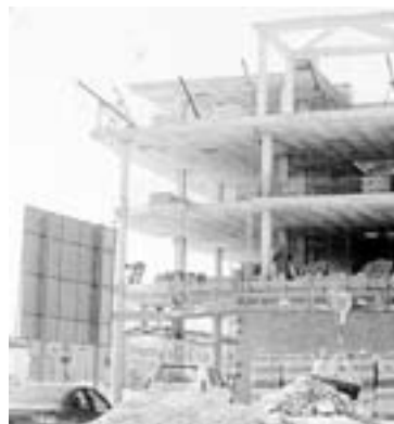
Obras. / J. CARRIÓN / AGM
