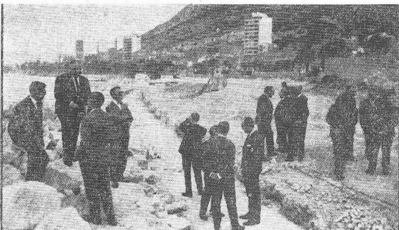
Una orden del Ministerio de Obras Públicas entregada ayer al alcalde de Alicante, hace constar la resolución de que la ciudad no verá disminuida la principal de sus playas: el Postiguet y la prolongación de la misma en "El Cocó". El citado Ministerio ha acordado también la cesión al Ayuntamiento alicantino de unos 16.000 metros cuadrados en la citada zona, para la que se proyecta un modernísimo complejo deportivo. Ayer el director general de Carreteras se reunió con las primeras autoridades alicantinas para concretar los acuerdos adoptados por el Ministerio en este sentido e iniciar las gestiones para la solución de otros graves problemas, como es la situación de la estación de clasificación y el tramo de vía que en la actualidad pasa junto a la playa del Postiguet y la Explanada. En el grabado, un momento de la visita del director general de Carreteras y autoridades alicantinas a la playa de "El Cocó". (Foto ANGEL GARCIA)
