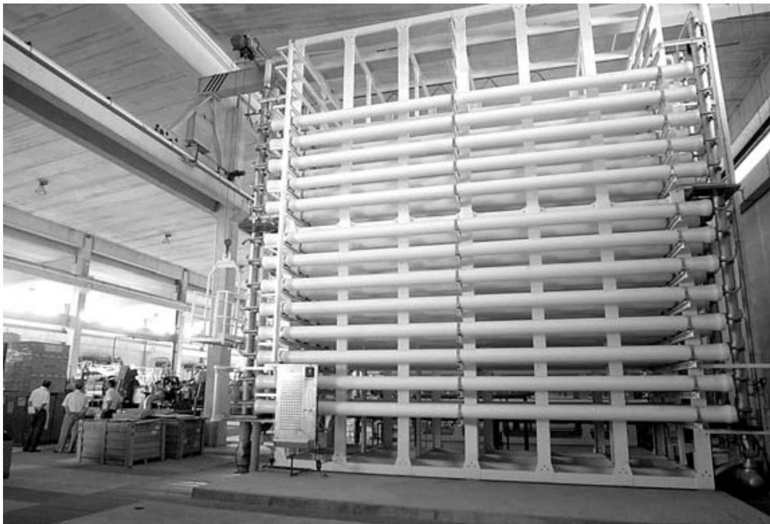
EN ESPERA. Tubos de membranas para desalinizar agua en la planta de San Pedro, que todavía está pendiente de varias obras. / A. GIL / AGM
