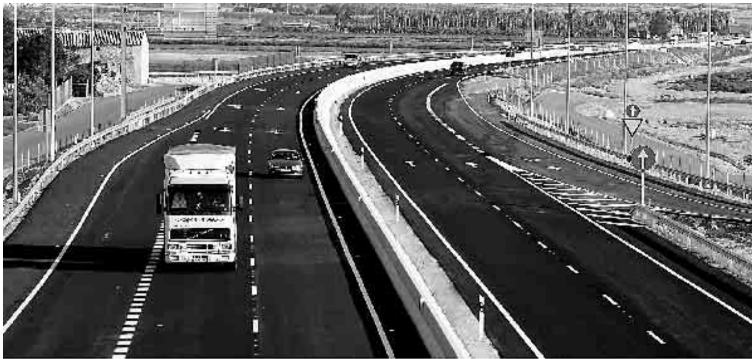
ESTRENO. Los primeros vehículos en circular por la nueva infraestructura, en una imagen tomada ayer por la tarde. / V. VICENS / AGM
