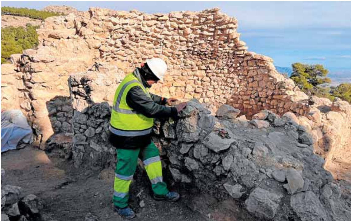
Un operario trabaja en la consolidación de uno de los pozos tradicionales. P. E.
