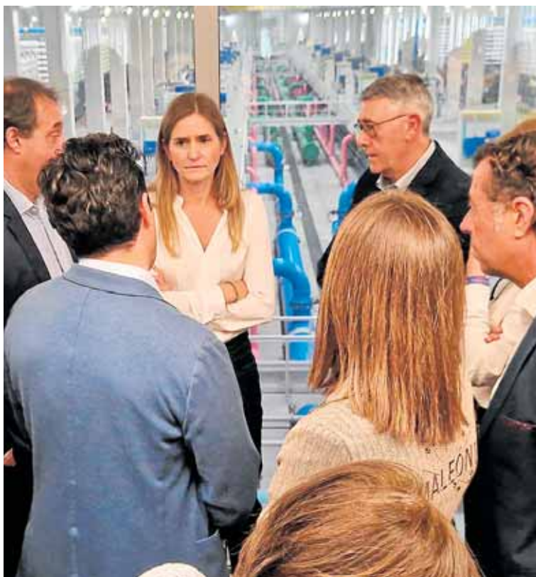
Parada en la desaladora de Águilas para revisar su ampliación. D. G.
