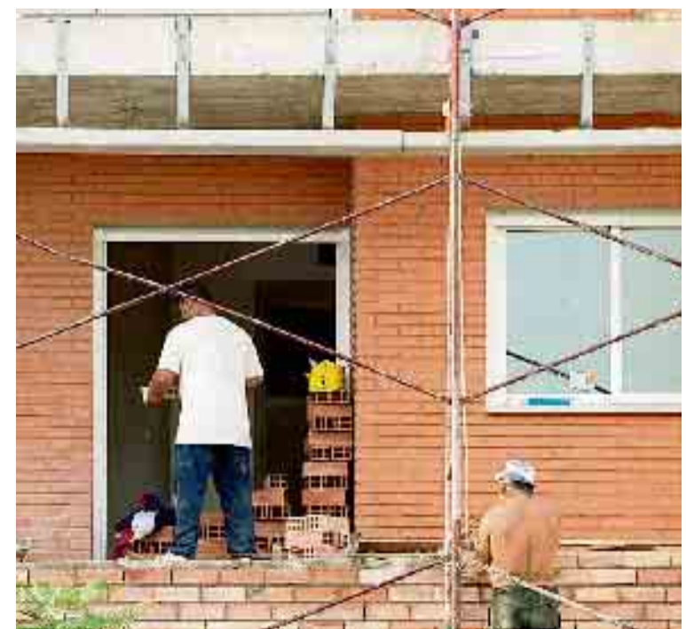
DESACELERACIÓN. Obreros trabajando en un bloque de casas. /EFE
