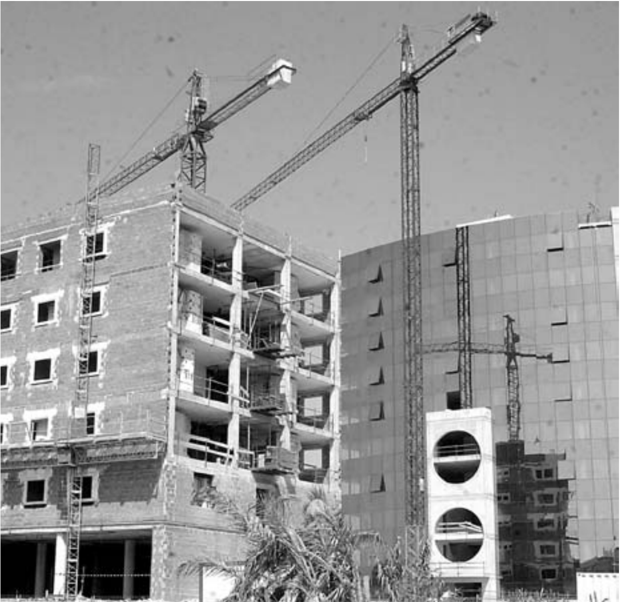
de dos edificios junto a la avenida de Juan Carlos I, en Murcia. / JAVIER CARRIÓN/AGM
