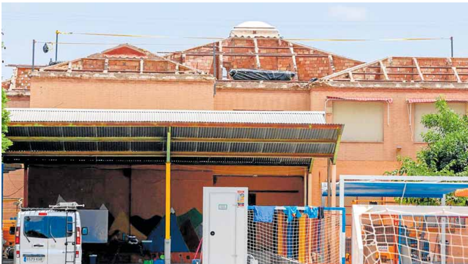
Aspecto exterior del colegio de Villaespesa, en el que ya ha sido retirada la cubierta de fibrocemento para construir la nueva. G. J. MARTÍNEZ / AGM
