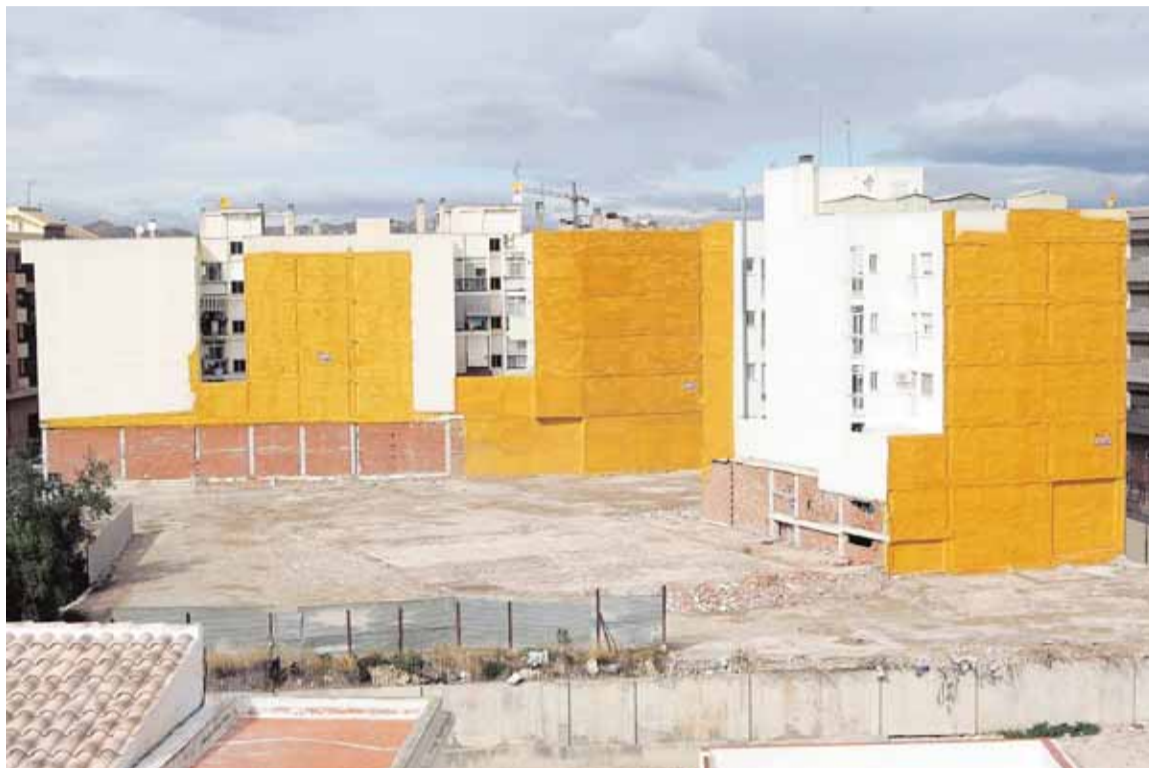
Solares vacíos en el centro de la ciudad, tras el derrumbe de las viviendas que los ocupaban como consecuencia de los seísmos. :: S. M. L. / AGM
