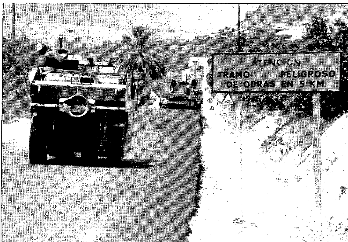
La Comunidad mantendrá el ritmo de inversiones. En la imagen, obras en la carretera de Archena. / J. LEAL
