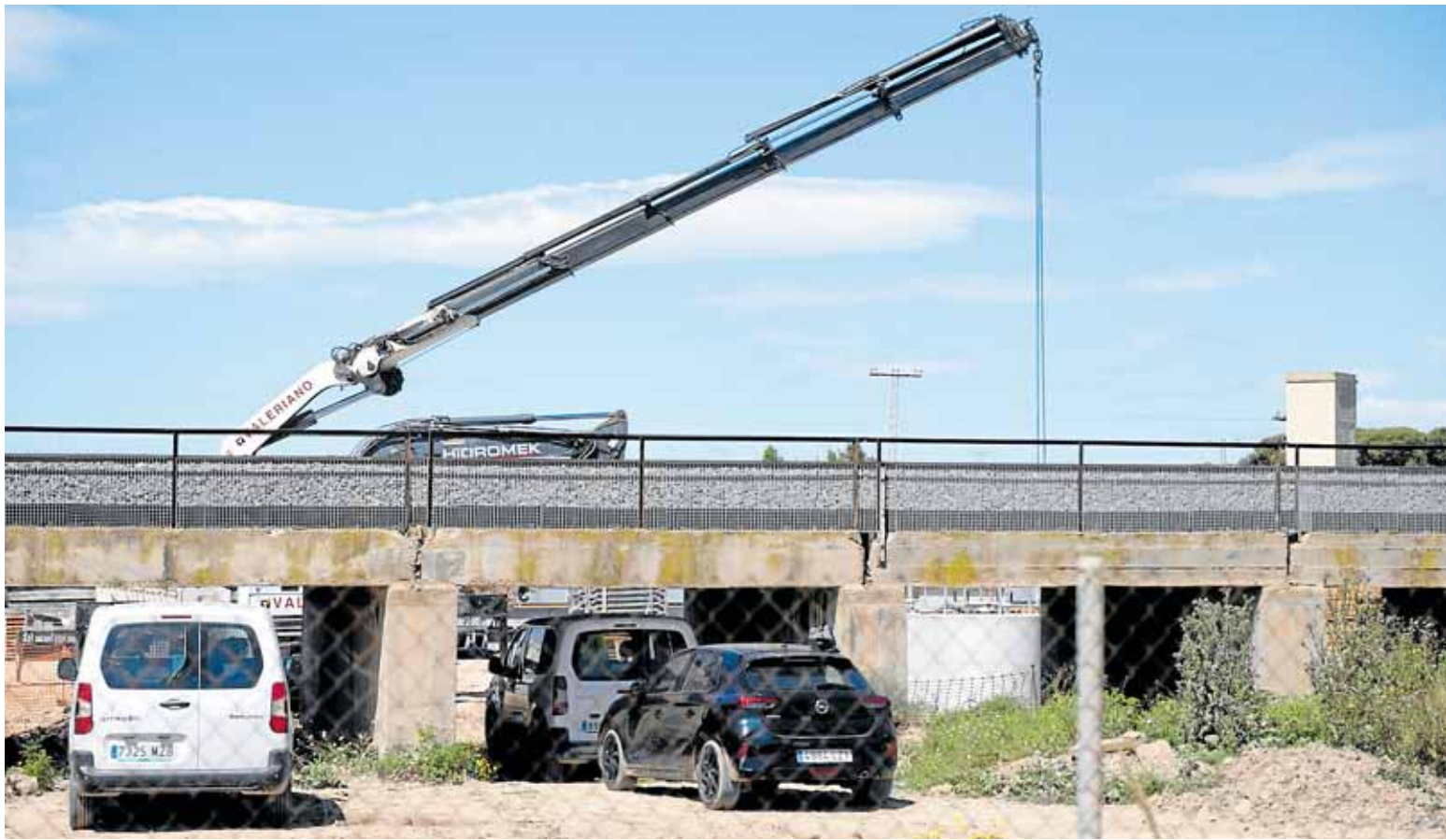
Obras para la llegada de la alta velocidad a Cartagena a la altura del municipio de Torre Pacheco, hace unas semanas. ANTONIO GIL / AGM
