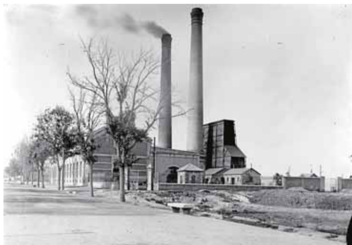
Fábrica de fluido eléctrico Hispania, en la Alameda de San Antón.
