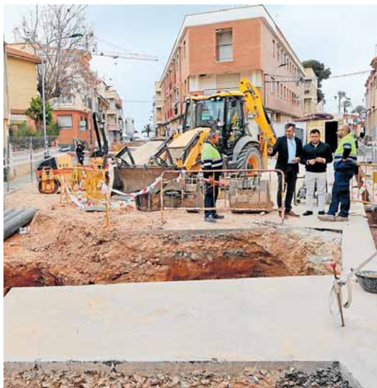
Nueva Estación de Bombeo de Aguas Residuales, en Lo Pagán. AYTO.
