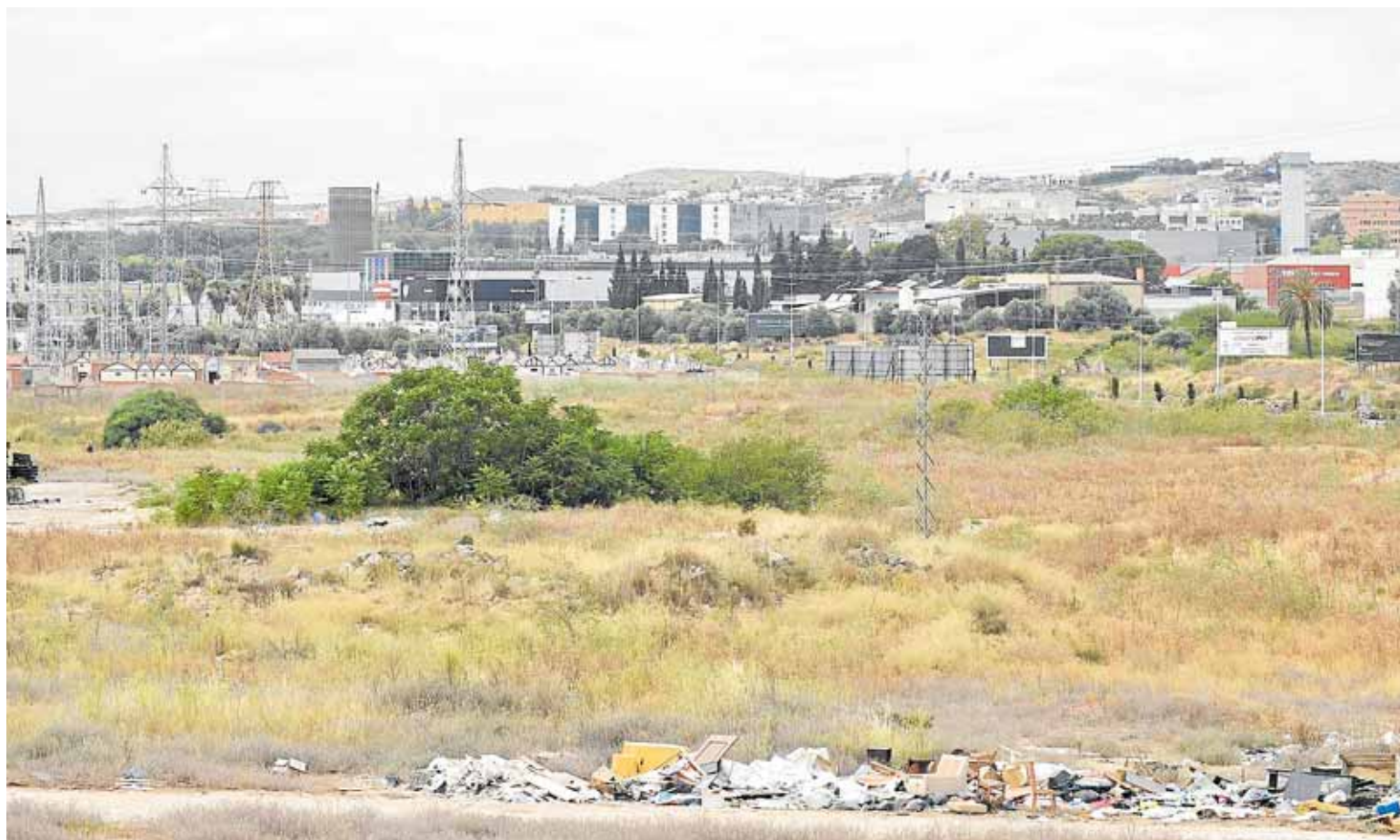
Panorámica de la zona que ocupará el futuro parque industrial; el área en torno al transformador eléctrico es la más avanzada. JAVIER CARRIÓN / AGM
