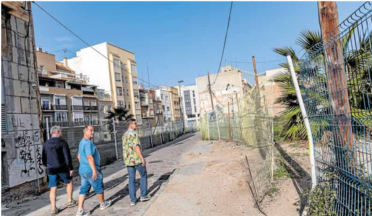
Tres viandantes caminan por la Morería Baja, entre una valla rota y adoquines en mal estado, en una imagen de archivo. J. M. RODRÍGUEZ / AGM
