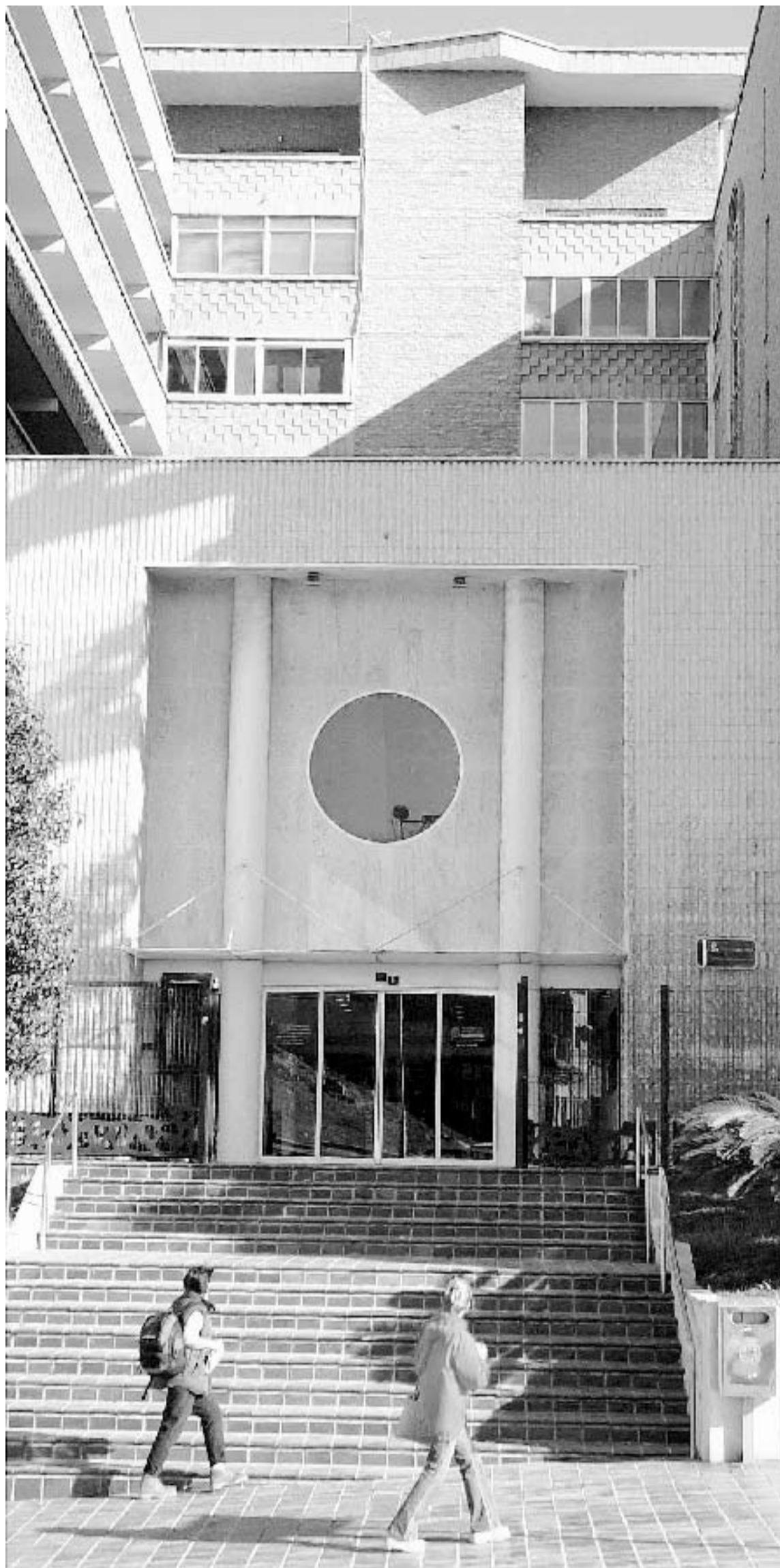
EDIFICIO ADMINISTRATIVO. Entrada principal al inmueble, en una imagen de archivo. / P. S. / AGM
