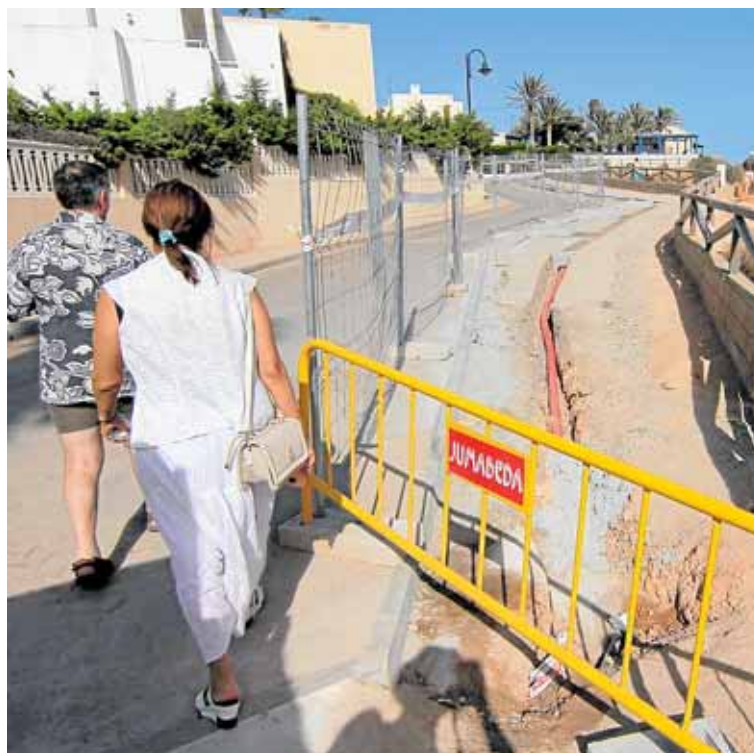
Una pareja camina por el paseo, inmerso en plenas obras. PEDRO MARTÍNEZ / AGM
