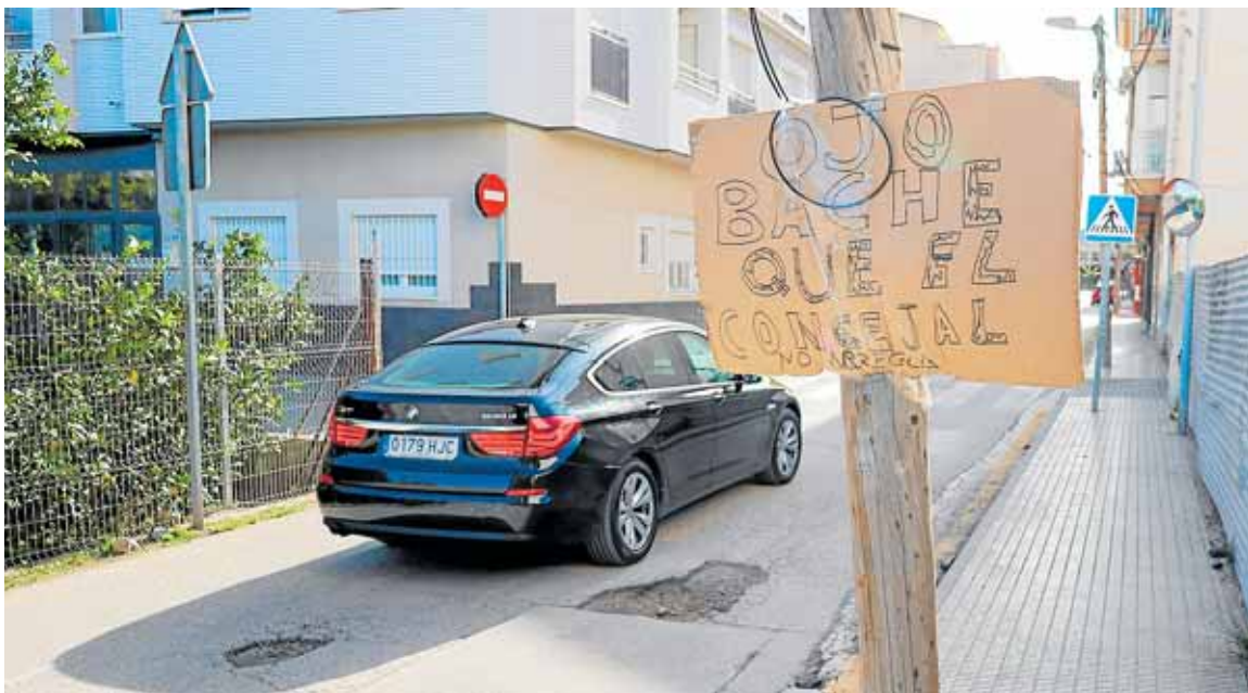
Cartel colocado por un vecino de Puente Tocinos para avisar a los conductores del bache. ANDRÉS MOLINA / AGM
