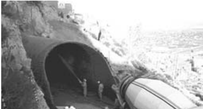
VIAL Y TÚNEL DE ACCESO AL PARADOR DEL CASTILLO
