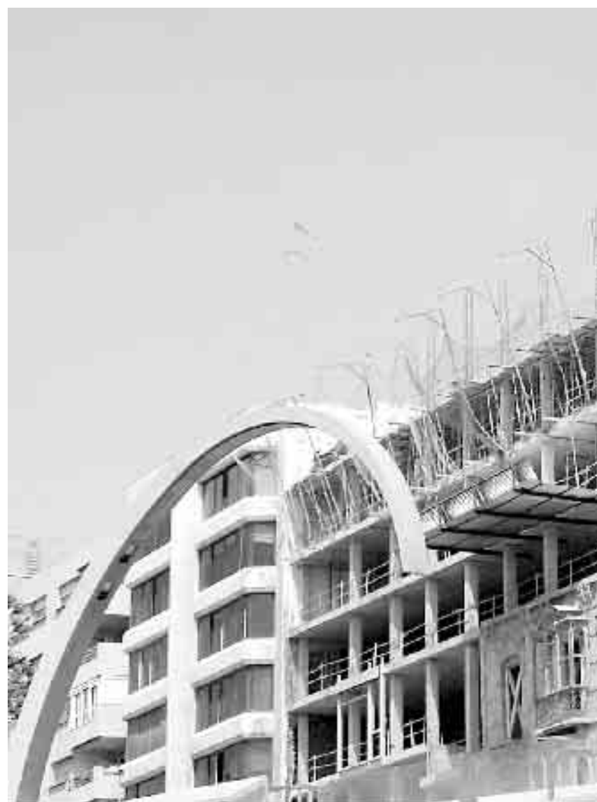
DESCENSO DE LAS VENTAS. Uno de los edificios en construcción en la
