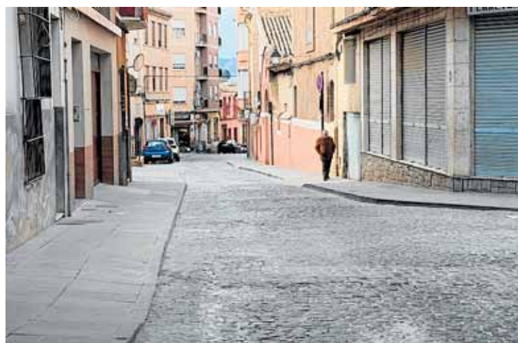
Calle Mesones, una de las zonas donde se realizarán las obras. c. c.
